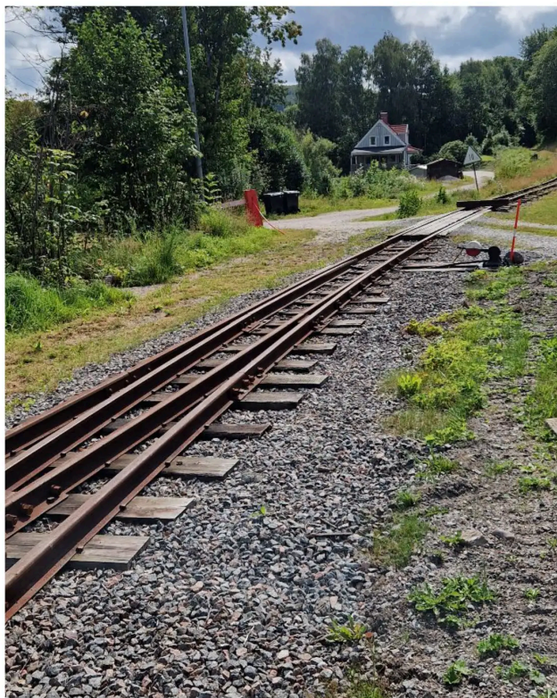
Dag Legnesjö: "Det är tråkigt att vi inte kan köra men vi har tagit tiden för att rusta upp spåren och även fixa till byggnaderna vi har här."
